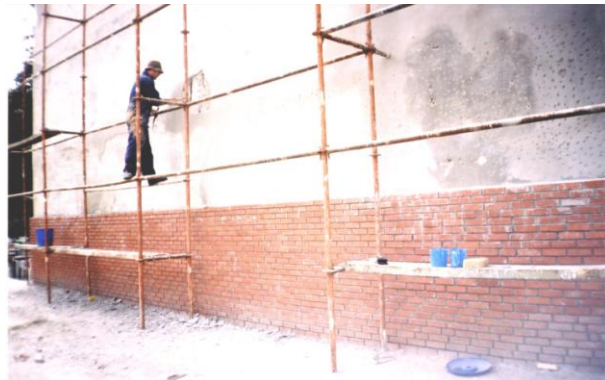
Yüzeyin montaj hazırlığı için onarımı
